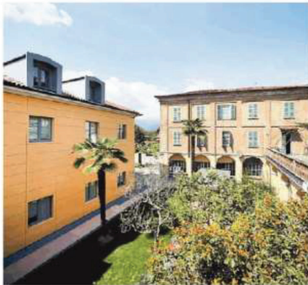
Il Residence del Frate di Bairo
